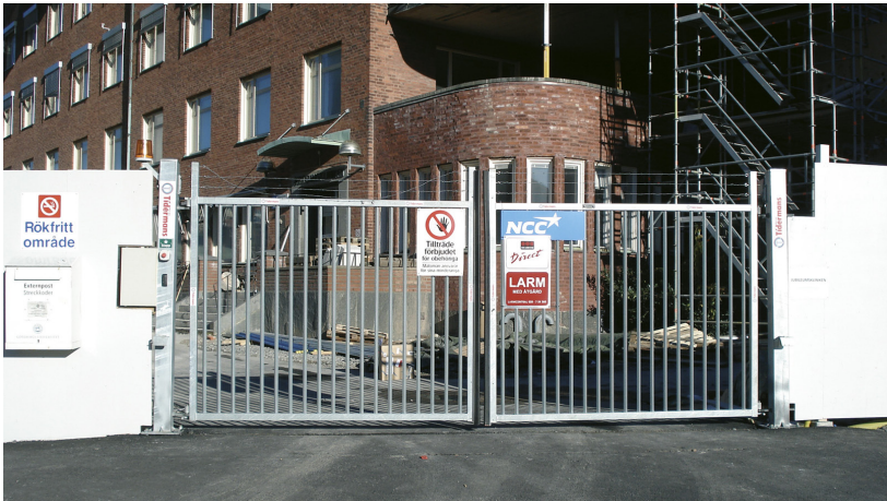
Motoriserad skjutgrind för passering av fordon. Flyttbar. Öppnas med ID06-kort.
